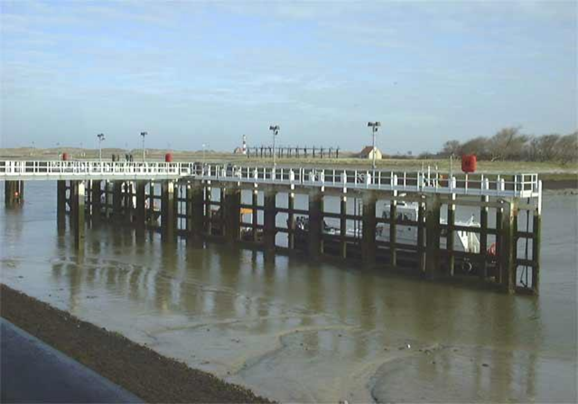
Bij de aanlegsteiger zie je de loods en de reddingsboten liggen.
